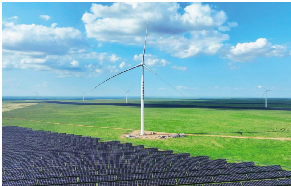
图 15-10 包头铝业 1200 兆瓦源网荷储配套新能源项目
